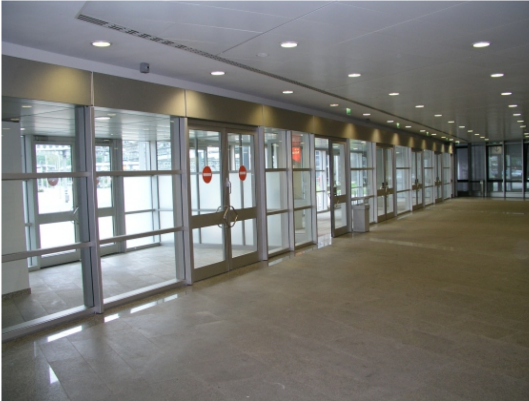
Windfanganlage Eingang Mitte
