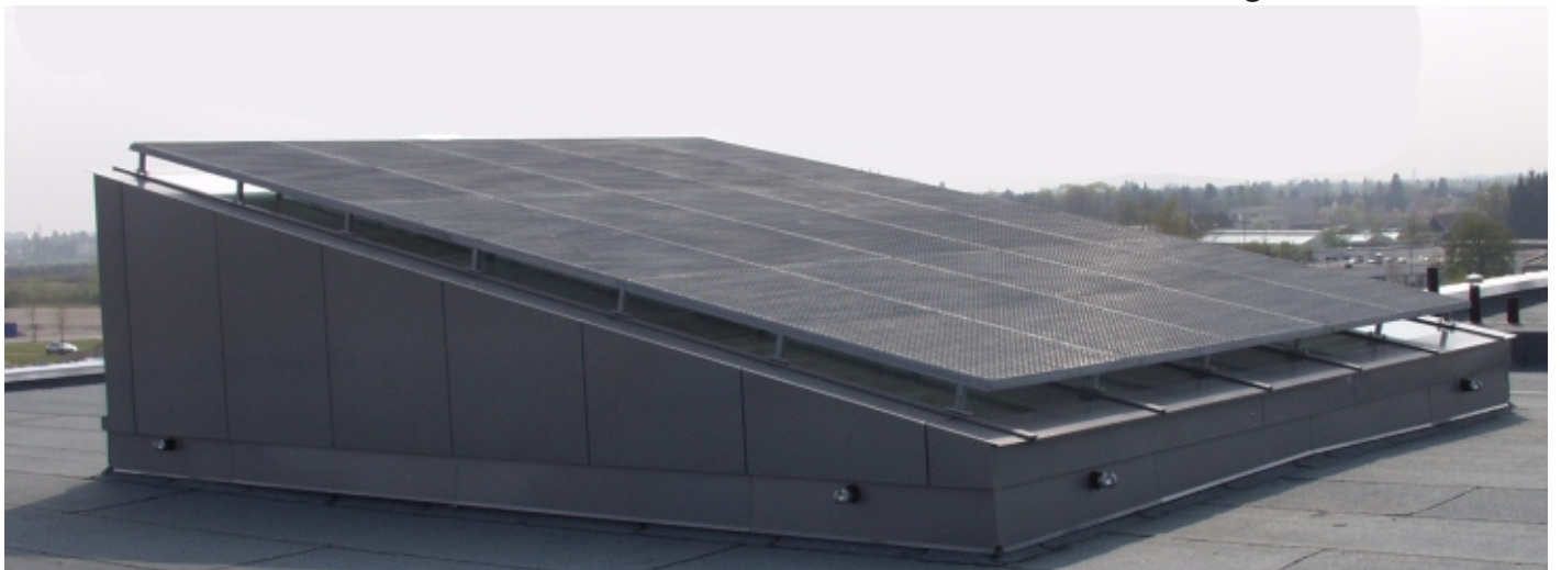
Verschattung durch Gitterrost
